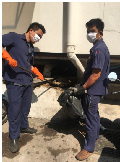
ภาพที่ 1-8 บ่อดักไขมัน และการดักไขมันของเจ้าหน้าที่ประจำโครงการ
