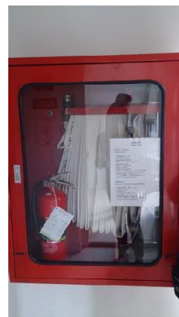
ภาพที่ 1-6 ท่อยืนหัวรับน้ำดับเพลิงและ Fire Host Cabinet
