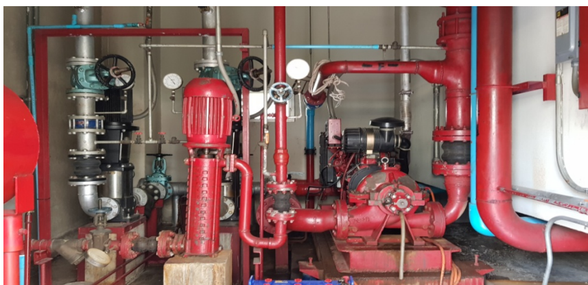
ภาพที่ 1-7 เครื่องสูบน้ำดับเพลิง
